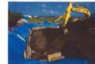
土工事(根切作業)※軟弱地盤での地山崩壊防止対策
